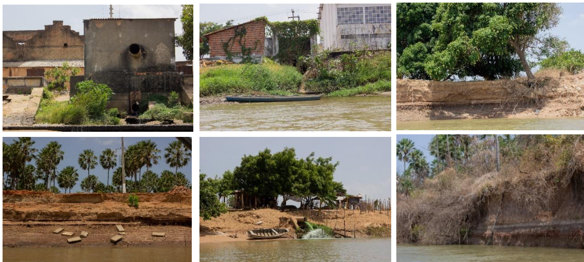
Figura 12 – Degradações observadas na área analisada do Rio Igarauçu
