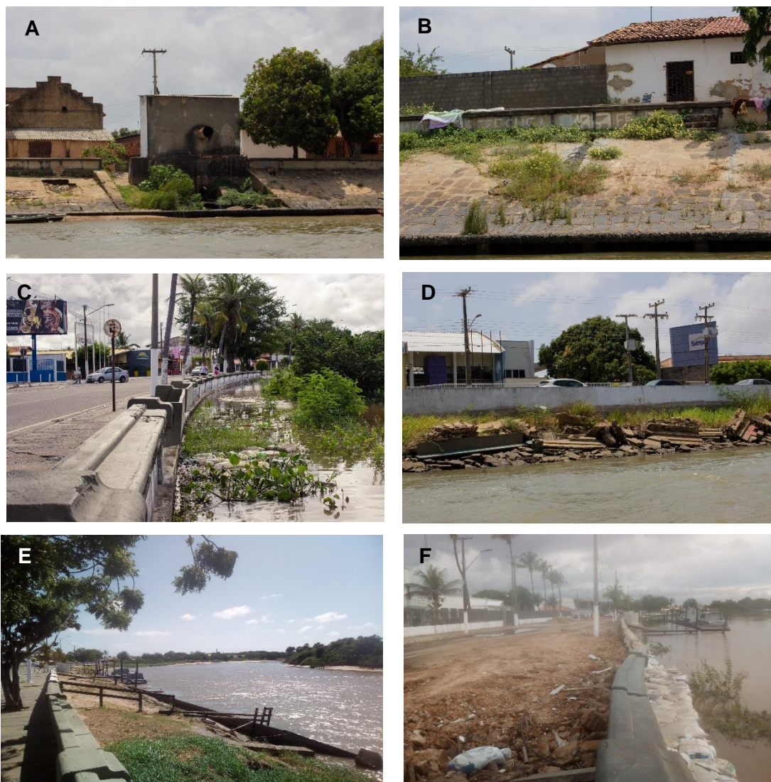
Figura 14 - Ações antrópicas e a relação física do Igarauçu. A, B e C – Descarregamento de dejetos diretamente sobre o rio; D – Erosão próximo ao leito, provocado pela enchente do rio; E – Comparação entre o período chuvoso e F- de estiagem do Igarauçu
