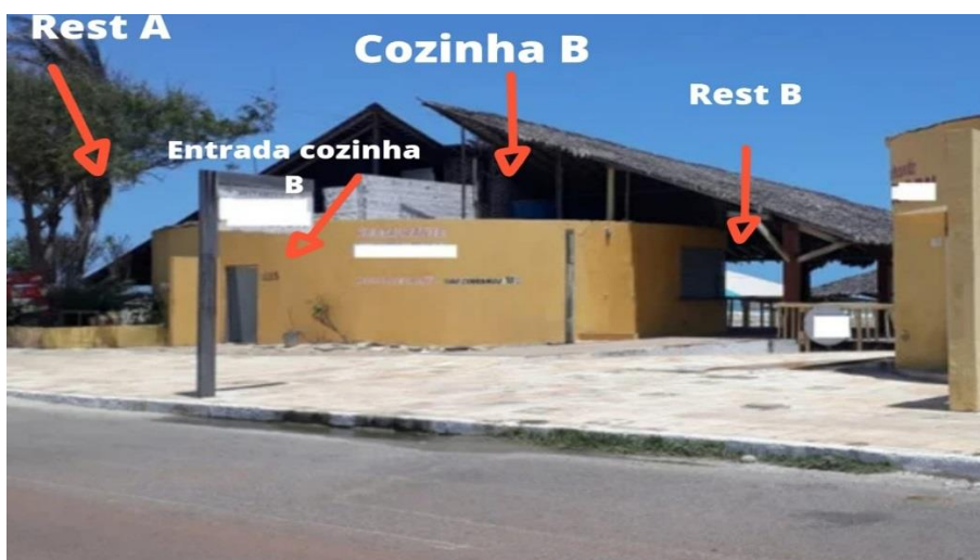
Figura 14 - Muro ao redor da cozinha
