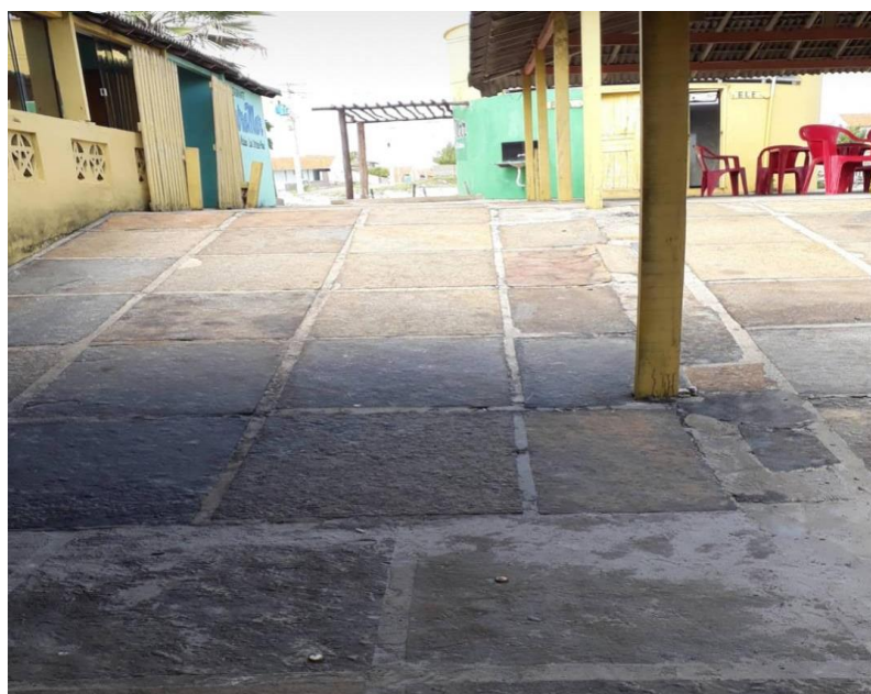
Figura 7 - Rampa de acesso à praia
