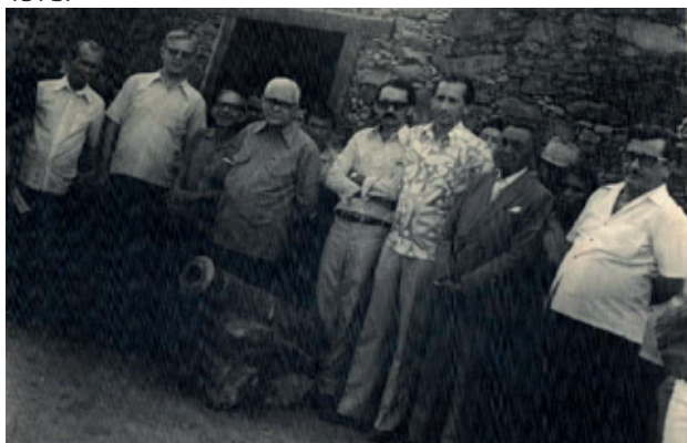
Figura 30 Solenidade de abertura da Casa da Pólvora após restauração realizada pela prefeitura municipal a partir da provocação do Instituto Histórico de Oeiras (IHO) em 1973.
