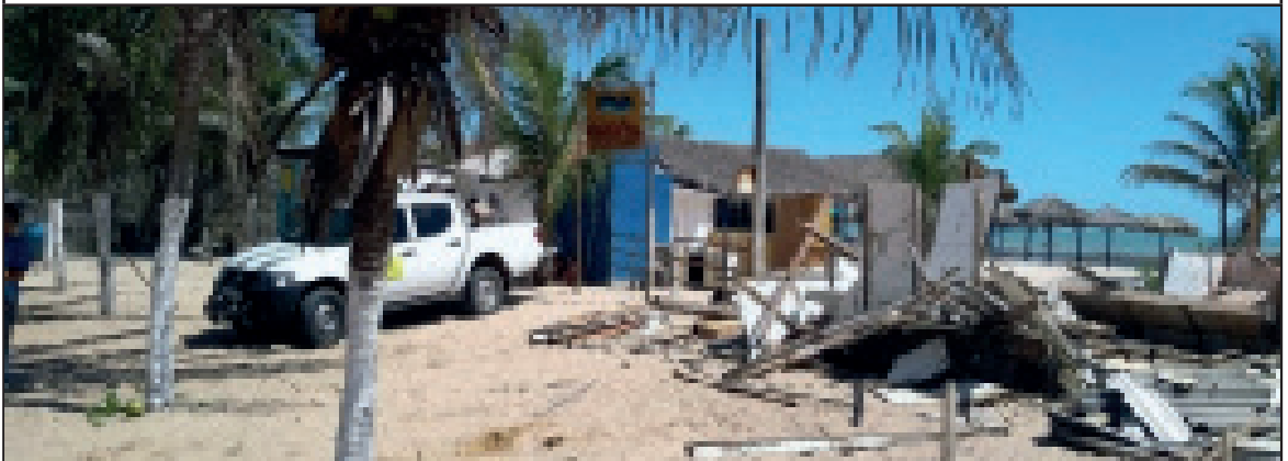
Figura 50 - Demolição de estruturas edificadas na orla da praia. | Fonte: Fotos de Cássia Moura.
