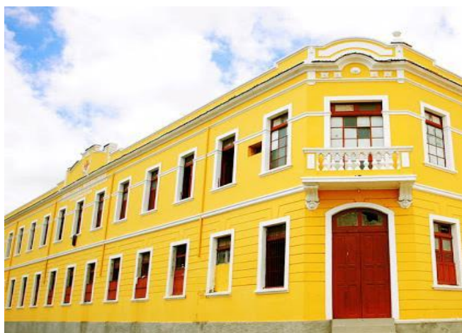
Figura 7. Ala psiquiátrica vista por fora do hospital, pelos fundos, visão das janelas cobertas até a metade por chapa de ferro e grades.
