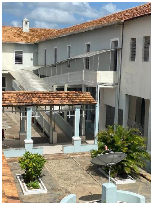
Figura 10. Rampa de acesso ao andar superior, lateral a ala psiquiátrica.
