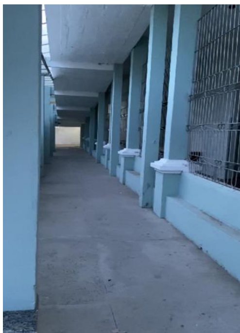
Figura 11. Corredor lateral a ala psiquiátrica, embaixo da rampa de acesso ao andar superior.
