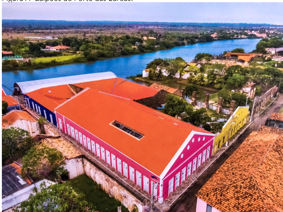
Figura 77 Galpões do Porto das Barcas.
