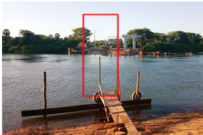
Imagem 05 - Imagem real da estrutura da ponte sobre o Rio Igarçu
